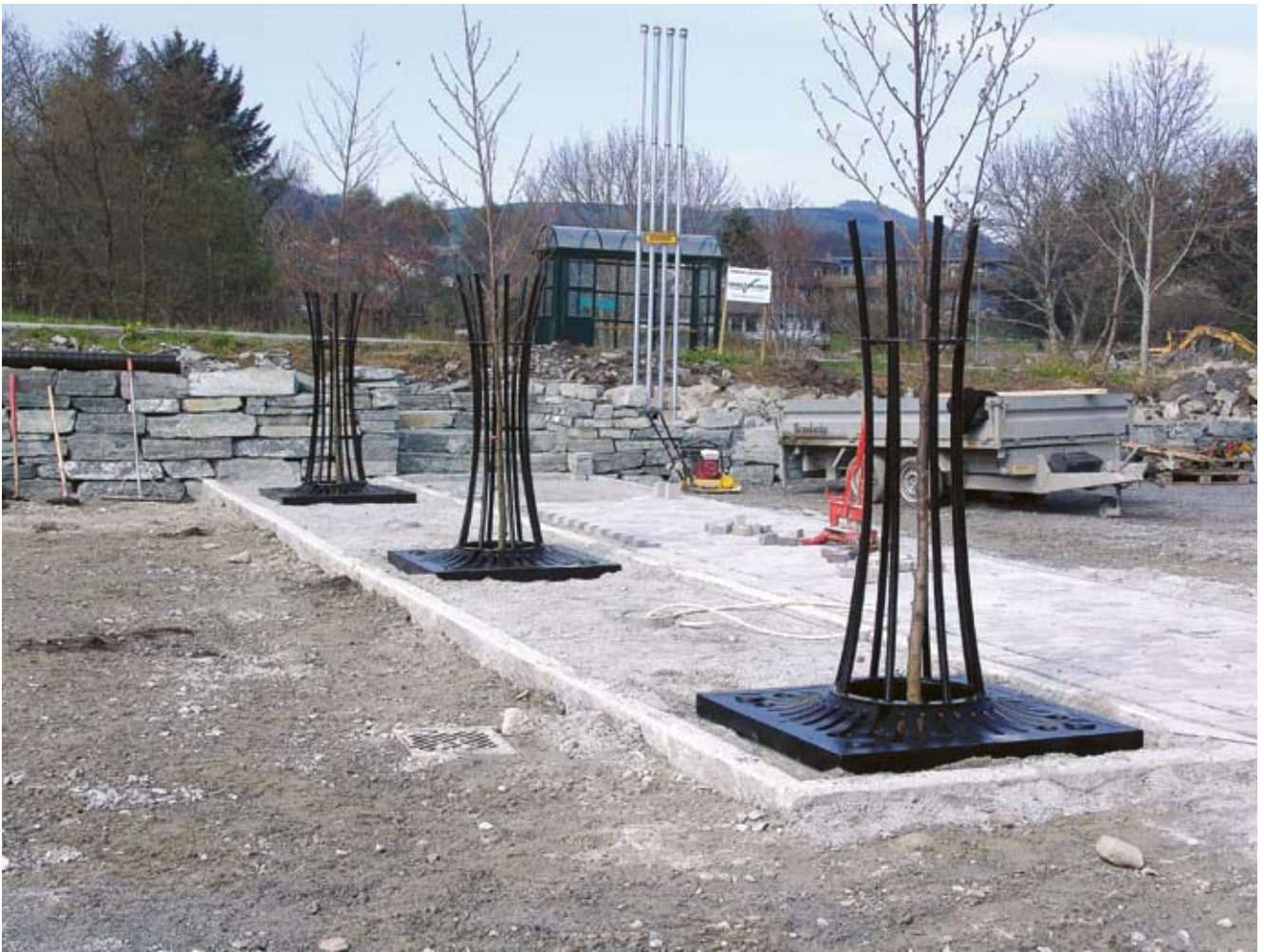
– Treplantekummen er støpt med forblendede utsparinger, som er enkle å slå ut. Kummene leveres i fem varianter. Den minste, som er benyttet her, rommer 1 kubikkmeter. Vi har utviklet kummene for at de skal være varige og lette å sette på plass. De er støpt i ett stykke, med hull i topp og bunn, forteller Jan Samuelson fra produsenten, Skjæveland Cementstøperi as. (foto: Komplett)
