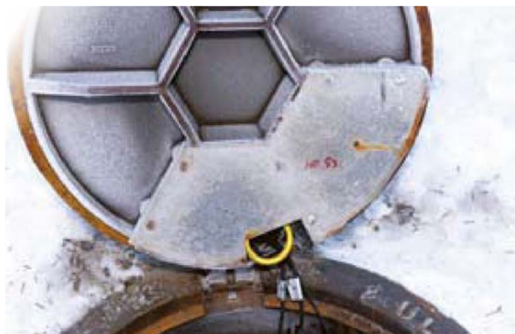
Et intelligent kumløkk klarer seg selv, alt ligger vanntett bak lokket som har alarm og lås.
