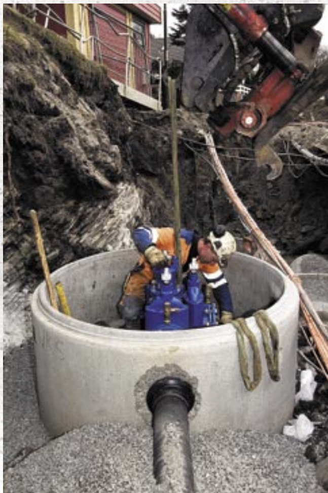
Armaturet heises ned i én trinnløs bevegelse, og i løpet av få minutter har Helge Wiken montert det.
